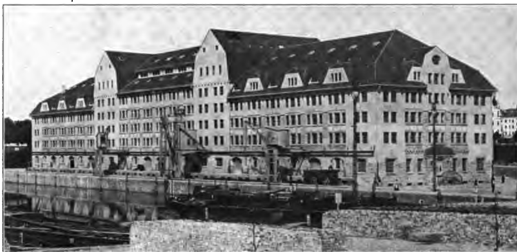
Abb. 33. Speicherbau am Tempelhofer Hafen bei Berlin.
